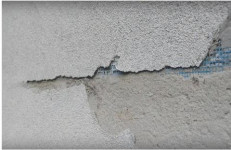
Primer (before plastering)
